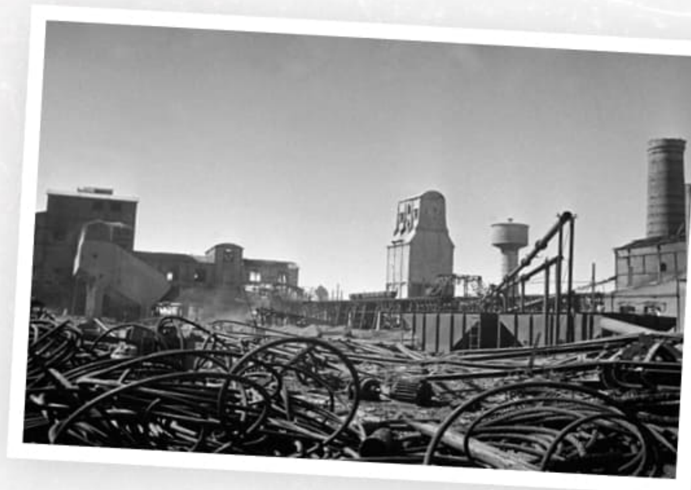
Разрушенные шахты Донбасса
